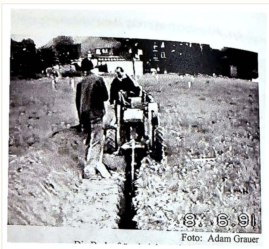
Foto: Adam Grauer. Die Bodenfräse bei der Arbeit.
