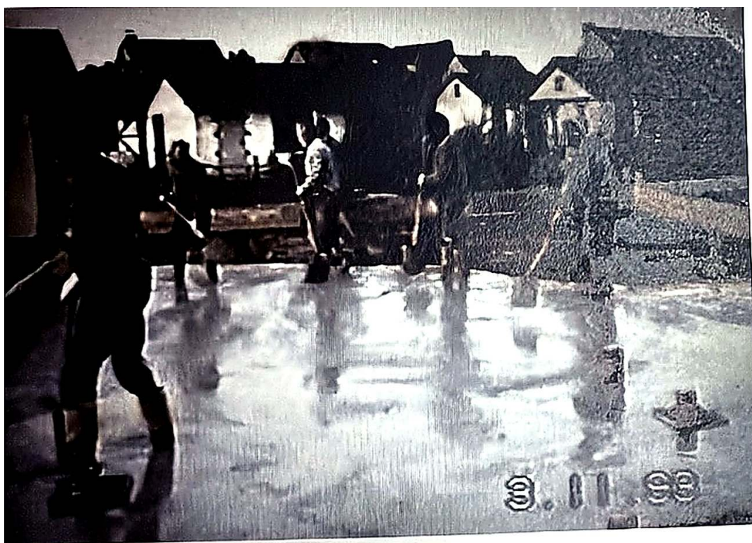
Foto aus der Chronik, datiert 03.11.1993: Die Bodenplatte des Vereinsheims ist gegossen.
