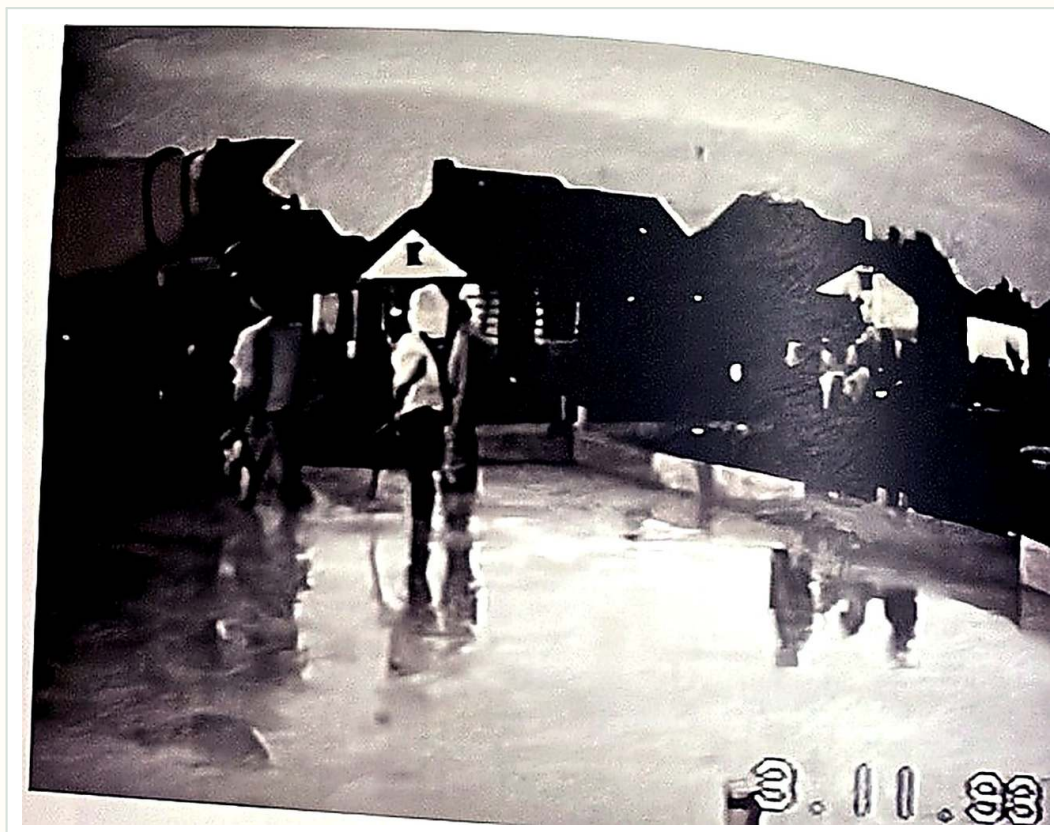
Foto: Adam Grauer. Vorbereitungen für den Bau des Vereinshauses, 08.11.1993.
