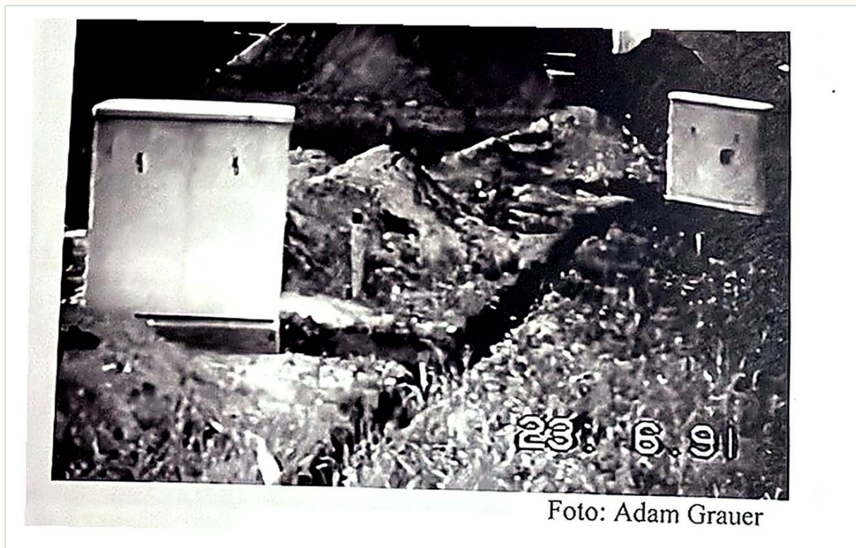
Foto: Adam Grauer. Die Stromkabel liegen bereits.
