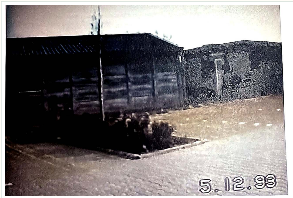
Foto aus der Chronik, datiert 05.12.1993: Vereinsheim im Rohbau, der alte Holzschuppen ist noch zu sehen.
